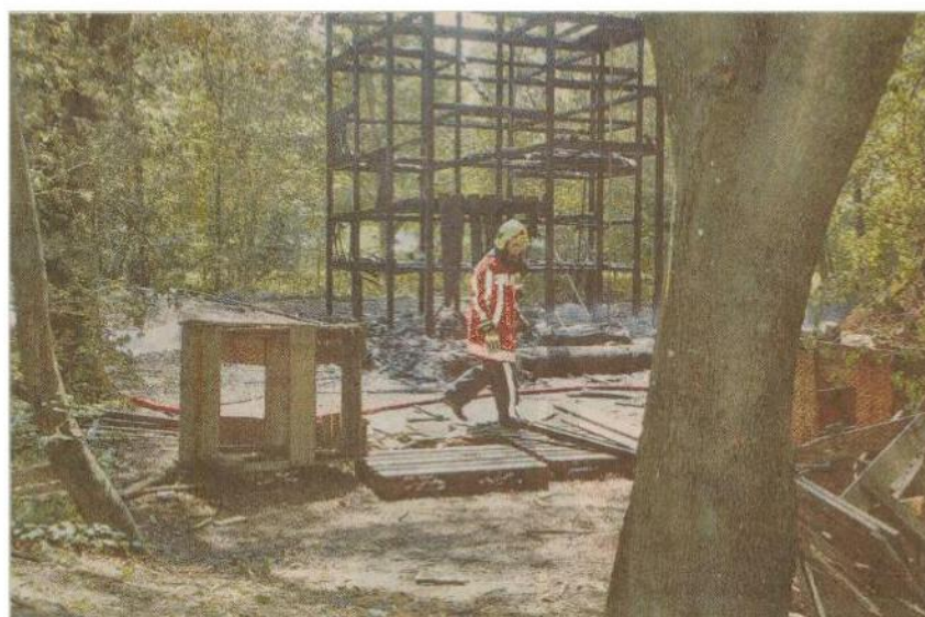
Der Spielplatz. Vom Kletterhaus ist nur das verkohlte Gerüst übrig. Foto Annette Boutellier
