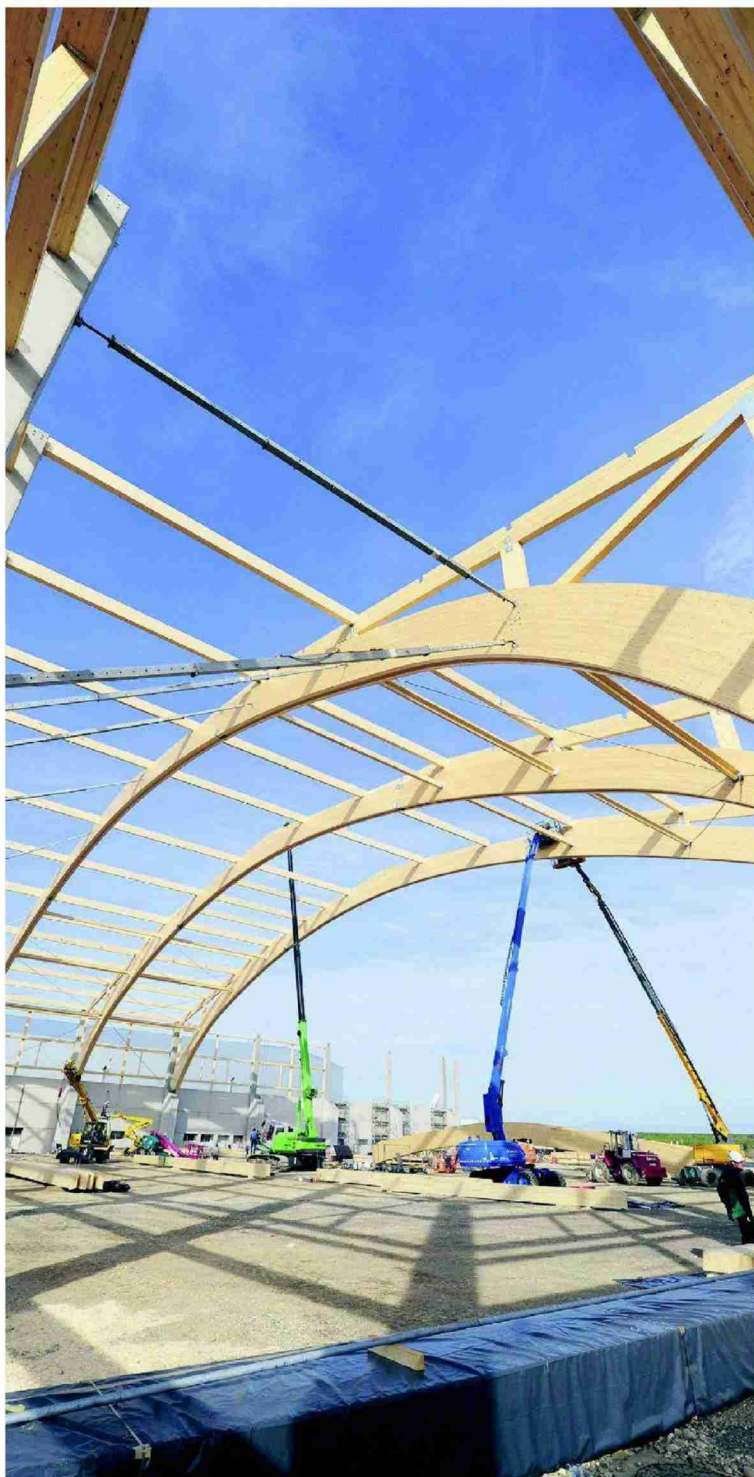
Amac lässt am Euro-Airport bereits den dritten Hangar bauen. KENNETH NARS
